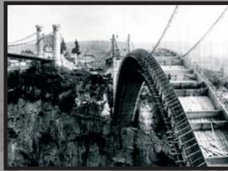
Construction du Pont de la Caille
